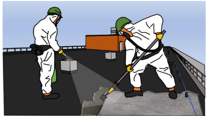
Retrait d'un revêtement amianté bitumineux
