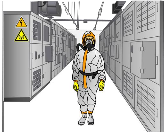
Intervention amiante « sous-section 4 » dans un local électrique TGBT
