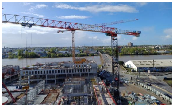
Le chantier du CHU à Nantes
